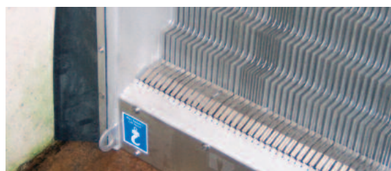
Решетка STEP SCREEN® Flexible – версия high efficiency, встроенная в существующий канал
