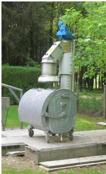
Пример установки решетки RoK4 на улице
