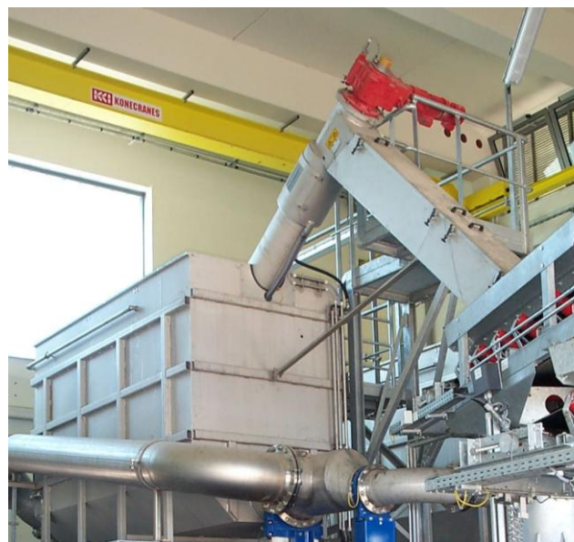
Пример исполнения барабанной решетки Ro1 в резервуаре
