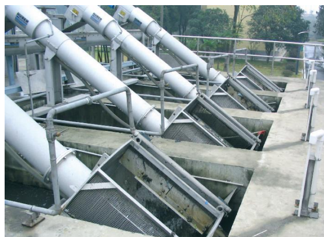
Несколько барабанных решеток Ro1, установленных параллельно
