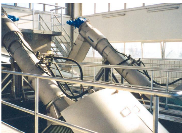
Брызгозащитный кожух для верхней части барабана решетки Ro1
