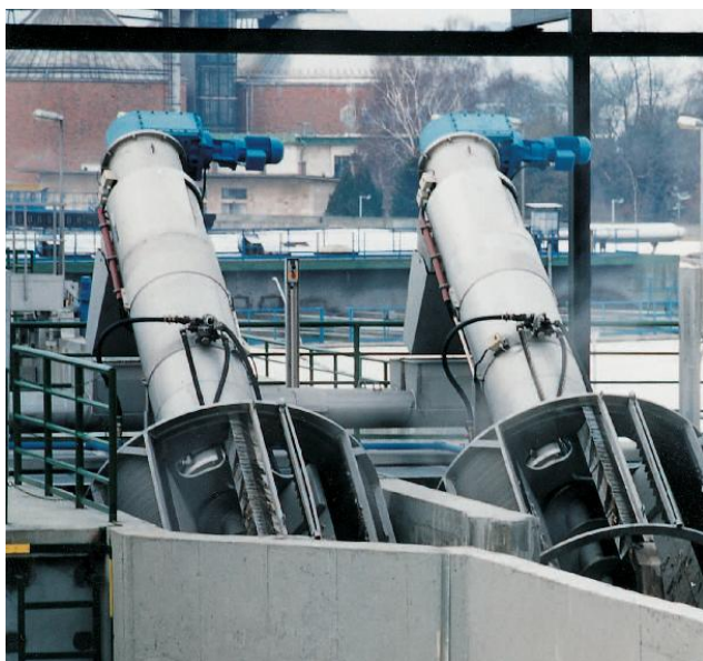
Пример исполнения барабанной решетки Ro1 в канале
