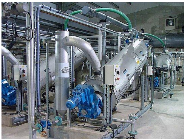
Шнековый пресс для обезвоживания осадка HUBER ROTAMAT® RoS 3
