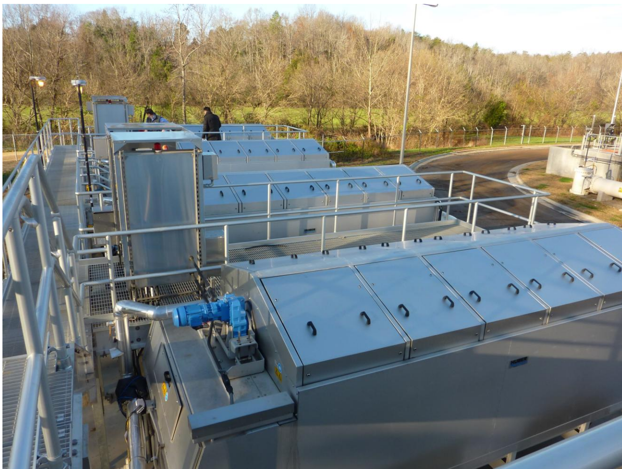
Пример исполнения дискового фильтра HUBER RoDisc® в резервуаре из нержавеющей стали
