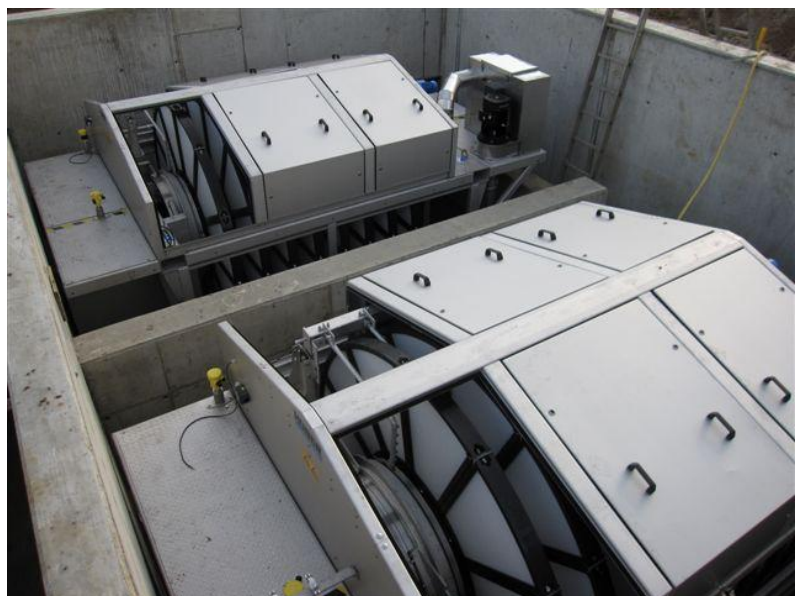
Пример исполнения дискового фильтра HUBER RoDisc® в бетонном резервуаре
