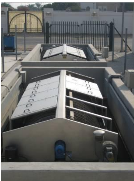
Пример исполнения дискового фильтра HUBER RoDisc® в бетонном резервуаре
