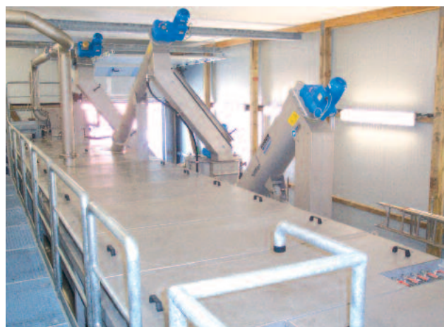
Герметичная выгрузка отбросов и песка из установки Ro 5 исключает распространение неприятного запаха
