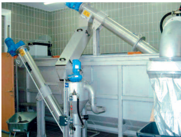
Выгрузка песка из песколовки в подключенную установку для промывки сухого песка HUBER RoSF 4/tC
