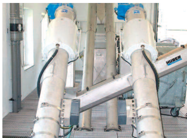
Установка Ro 5 в подземном исполнении с резервированием
