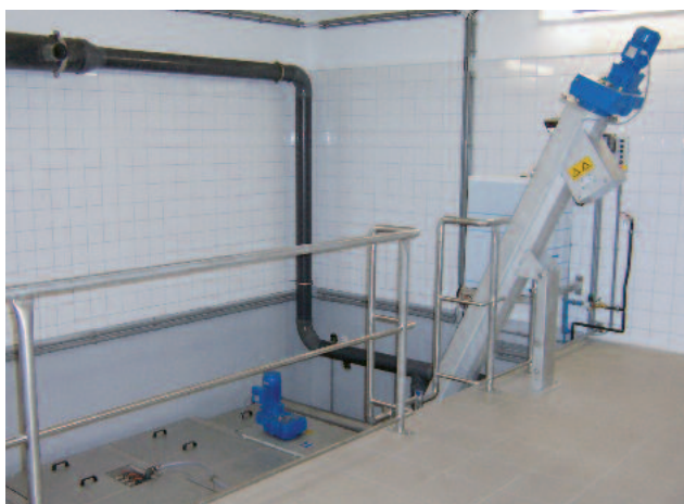
Встроенный в конце песколовки установки Ro 5 пескопромыватель
