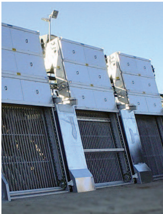
Универсальная решетка Huber RakeMax® : подходит для установки в широкие каналы
