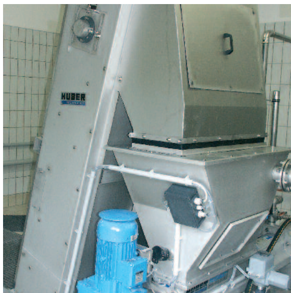
Решетка HUBER RakeMax® с подключенным моечным прессом для отходов HUBER WAP/SL
