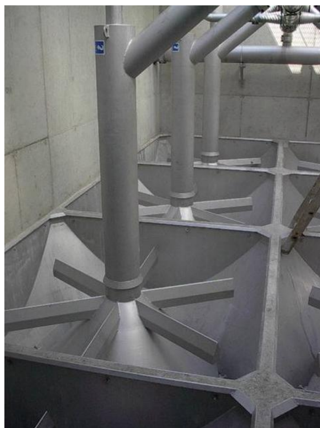
Пример исполнения песчаных фильтров HUBER CONTIFLOW® в бетонном бассейне
